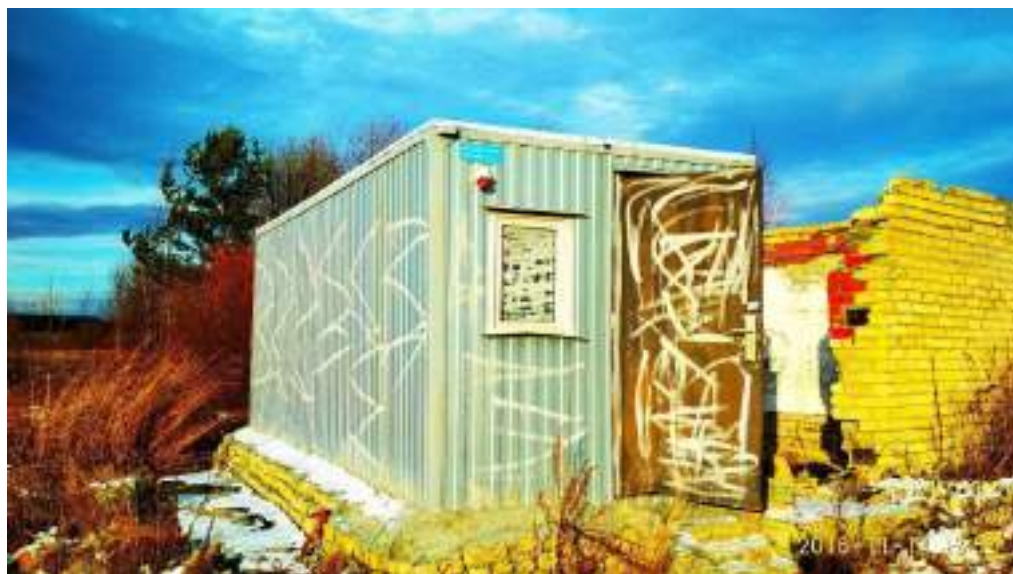
Рисунок 2. Здание над скважиной "Земледелец"
