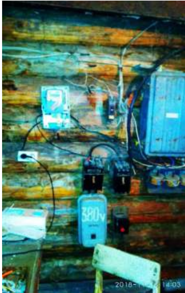
Рисунок 6. Прибор учета потребления электрической энергии скважины по ул. Пионерская, 54
