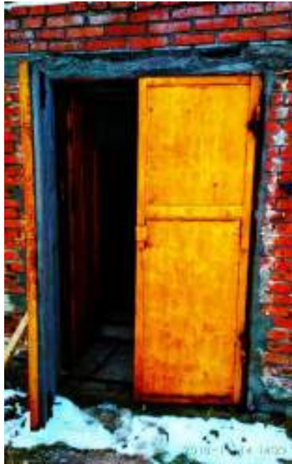
Рисунок 43. Здание насосной станции перекачки очищенных стоков (снаружи)
