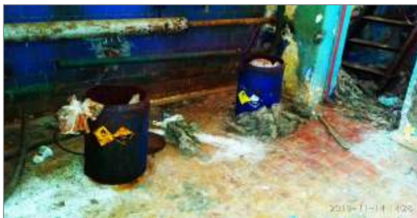
Рисунок 40. Здание хлораторной (внутри)
