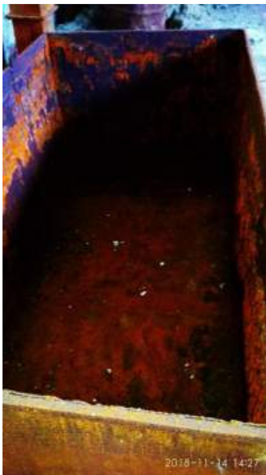
Рисунок 42. Емкость (бак) для хлора
