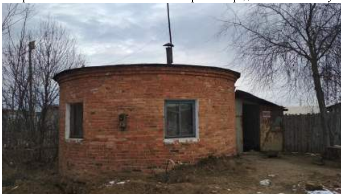
Рисунок 11. Здание КНС №1 (снаружи)
