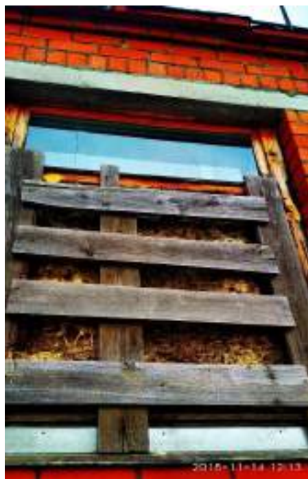
Рисунок 31. Здание КНС №6 (снаружи)
