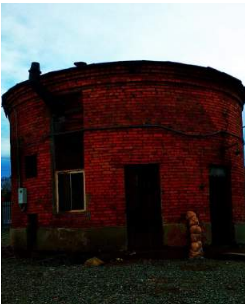
Рисунок 16. Здание КНС №2 (снаружи)
