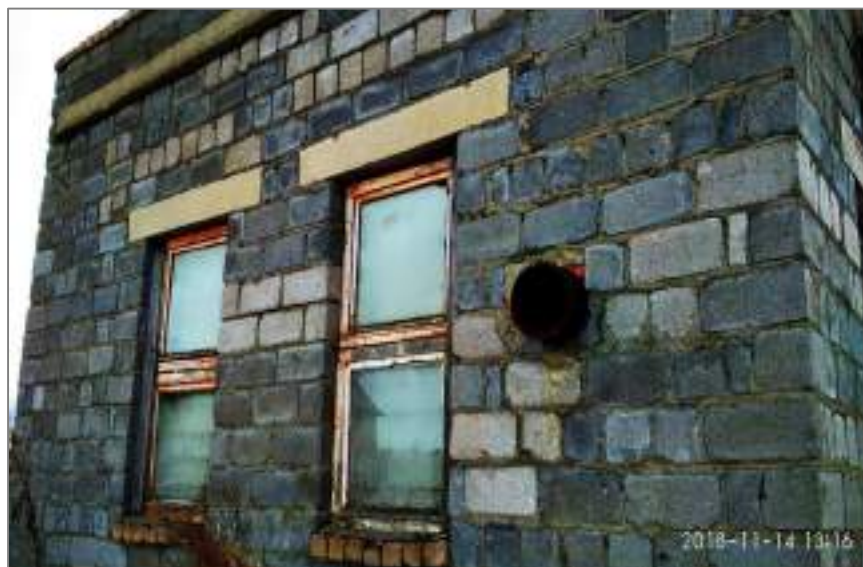
Рисунок 29. Здание КНС №5 (снаружи)
