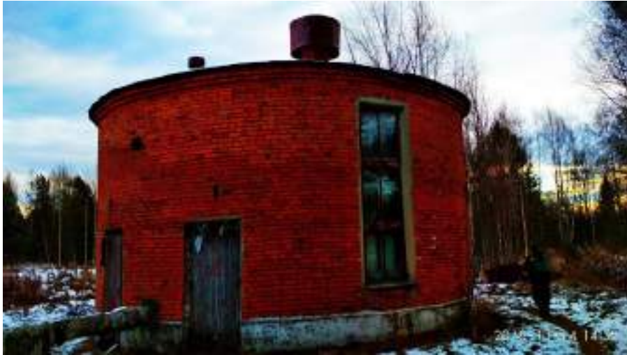
Рисунок 47. Здание насосной станции бытовых стоков (дренажные очистные сооружения)
