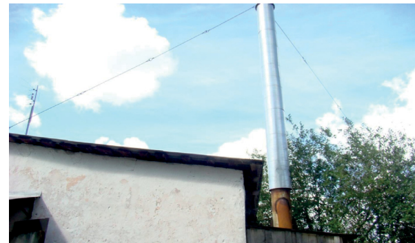
Рисунок 9. Общий вид котельной по ул. Карла Маркса, 35
