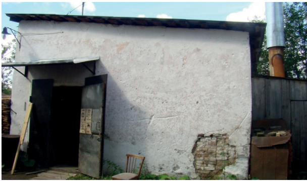
Рисунок 10. Общий вид котельной по ул. Карла Маркса, 35
