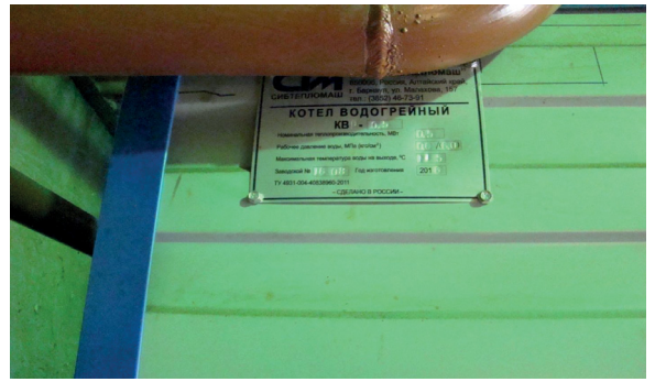
Рисунок 11. Общий вид водогрейного котла КВР-0,5
