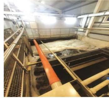
Рисунок 24. Вторичный отстойник
