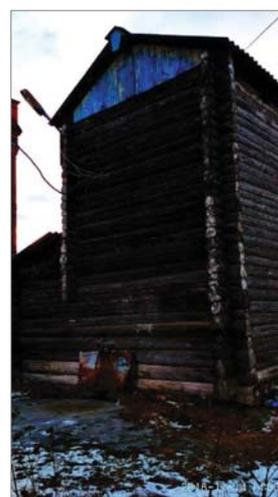
Рисунок 3. Водонапорная башня-сруб
