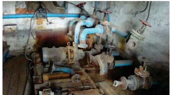
Рисунок 16. Общий вид сетевого насоса марки КМ 80-50
