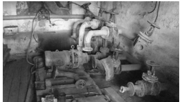
Рисунок 16. Общий вид сетевого насоса марки КМ 80-50
