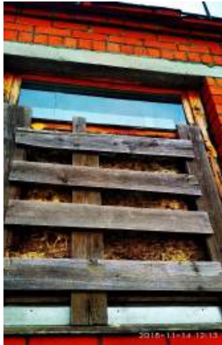
Рисунок 31. Здание КНС №6 (снаружи)
