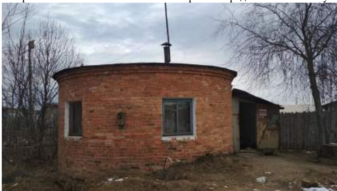
Рисунок 11. Здание КНС №1 (снаружи)
