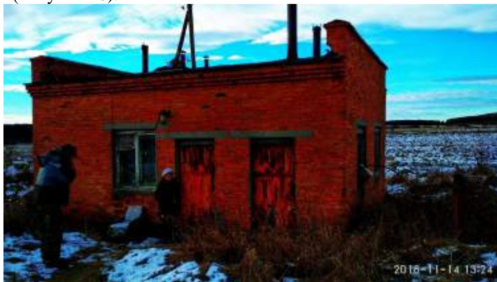
Рисунок 20. Здание КНС №3 (снаружи)
