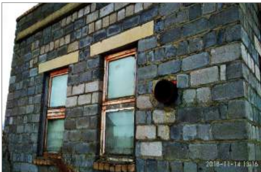
Рисунок 29. Здание КНС №5 (снаружи)
