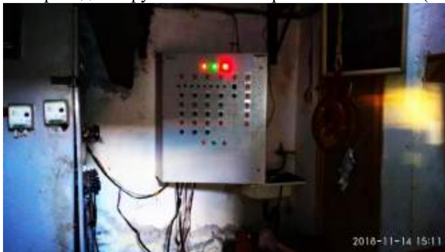
Рисунок 32. Шкаф управления КНС №6
