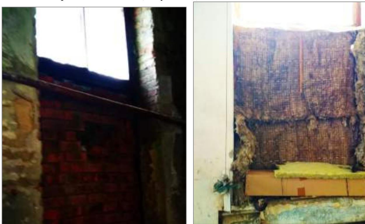
Рисунок 24. Здание КНС №4 (внутри)
