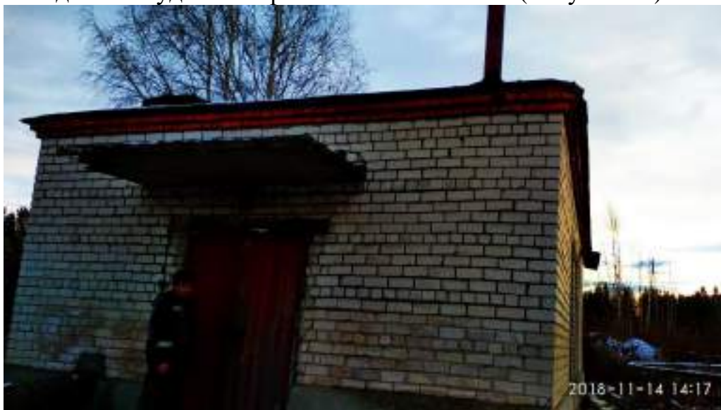
Рисунок 34. Здание насосной станции стоков возврата иловой воды и насосной станции сырого осадка
