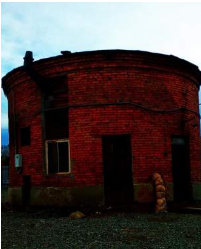
Рисунок 16. Здание КНС №2 (снаружи)
