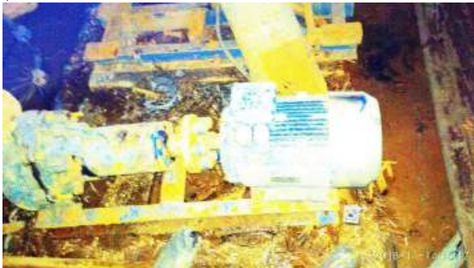
Рисунок 33. Насосный агрегат КНС №6
